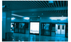
Şangay Metro İstasyonu / Çin
