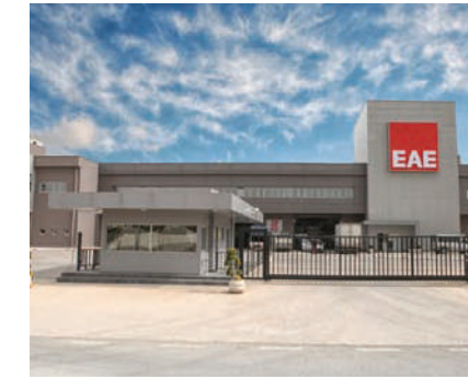
EAE Elektrik Fabrikaları Dilovası - Kocaeli Fabrika çevresi, rampalar ve yükleme alanları kar ve buz önleme, 1183 m²
