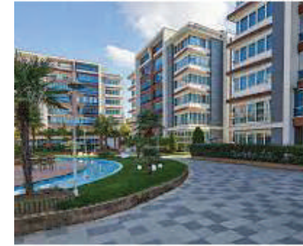
Hayat Park - İstanbul 72 daire hamam iç mekan ısıtma, 324 m²
