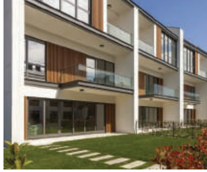
Köy - Zekeriyaköy - İstanbul Sprinkler tracing, 3580 m Rampa kar ve buz önleme 816 m²
