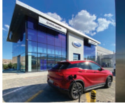
Ford Çetinkayalar - Elazığ Showroom iç mekan ısıtma, 741 m²
