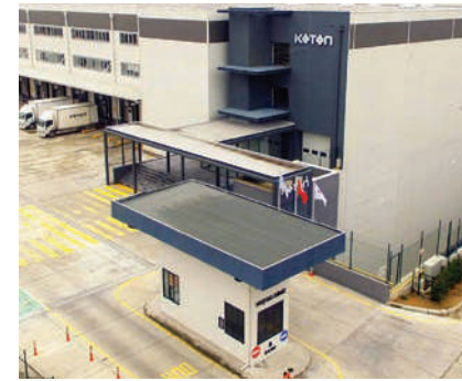
Koton Merkez Depo - Gebze-Kocaeli Çatı oluk kar ve buz önleme tracing, 2303 m
